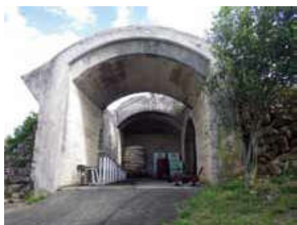
電波探知機壕Ⅰ（基地内）
