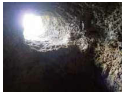
砲口（壕内部より）
