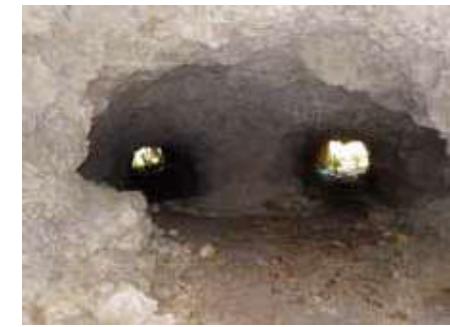
こうないぶ 壕内部
