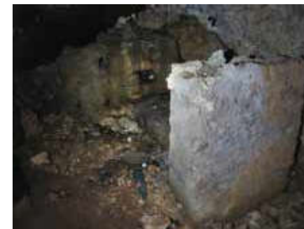
爆風避けと思われるコンクリートの壁
